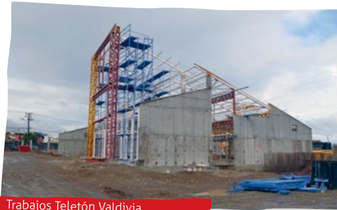
Trabajos Teletón Valdivia
